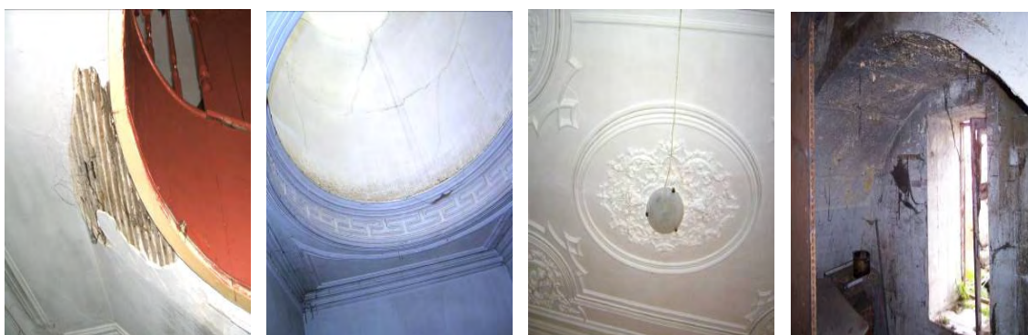
Caixa de escada
