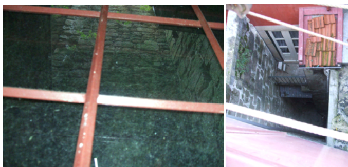
Saguões em edifícios reabilitados
