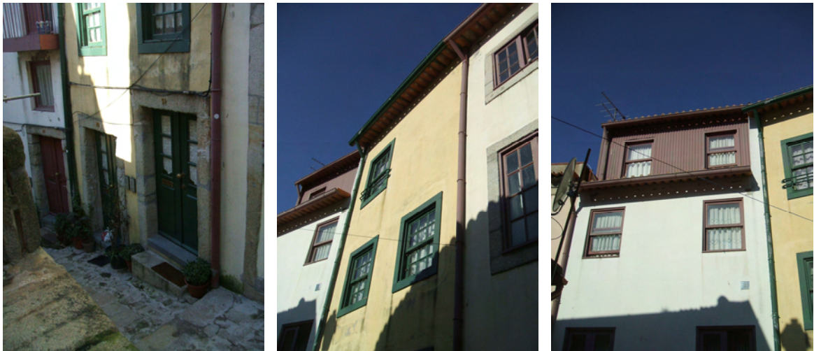
Parcelas reabilitadas na Rua de Pena Ventosa
