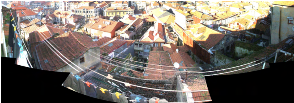
Vista panorâmica do sector central do quarteirão, prédios em ruína volvidos à Rua da Bainharia (parcelas 10,13 e 14)
