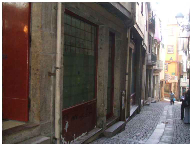
Frente (R/c) da parcela 24, emparcelamento de vários edifícios
