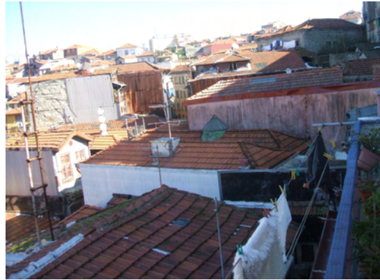
Vista da fachada tardo de um edifício da rua de Pena Ventosa, sobre os telhados dos edifícios voltados à rua da Bainharia
