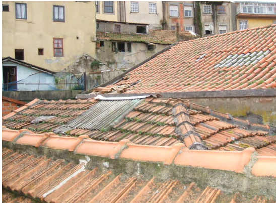
Telhados dos edifícios com frente para a Rua da Bainharia e vista das fachadas tardo das frentes urbanas voltadas às ruas de S. Sebastião e de Pena Ventosa
