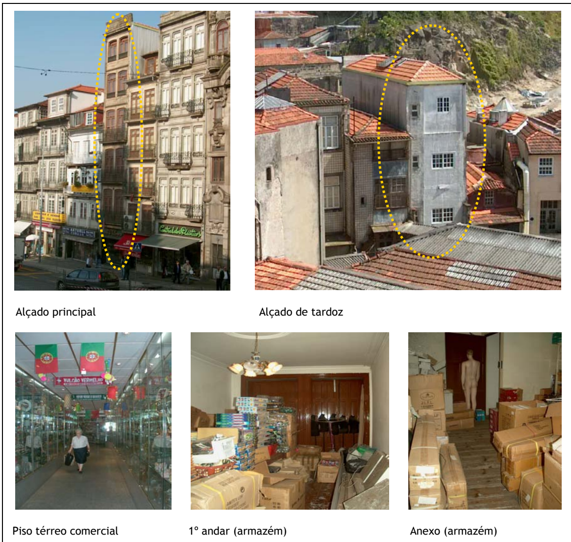
Fig. 1 - Exemplo de parcela de elevada altura e de diminuto vão transversal que prevalece na frente urbana da Pr. de Almeida Garrett / Rua das Flores, com afectação total do uso à actividade sedeadada no piso térreo e utilização dos pisos superiores como armazenamento
