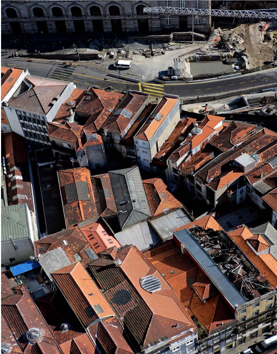
Fig. 3 – Vista aérea do interior do quarteirão, totalmente preenchido com construções secundárias. À direita, em baixo, pode observar-se o que resta do edifício atingido por violento incêndio (foto F. Piqueiro)
