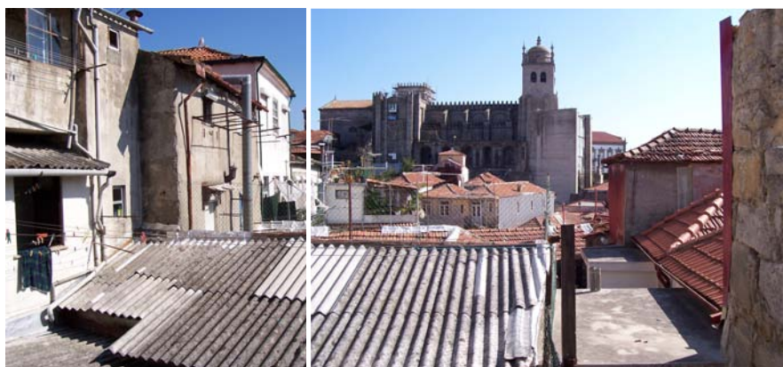
Vista actual do interior do bairro
